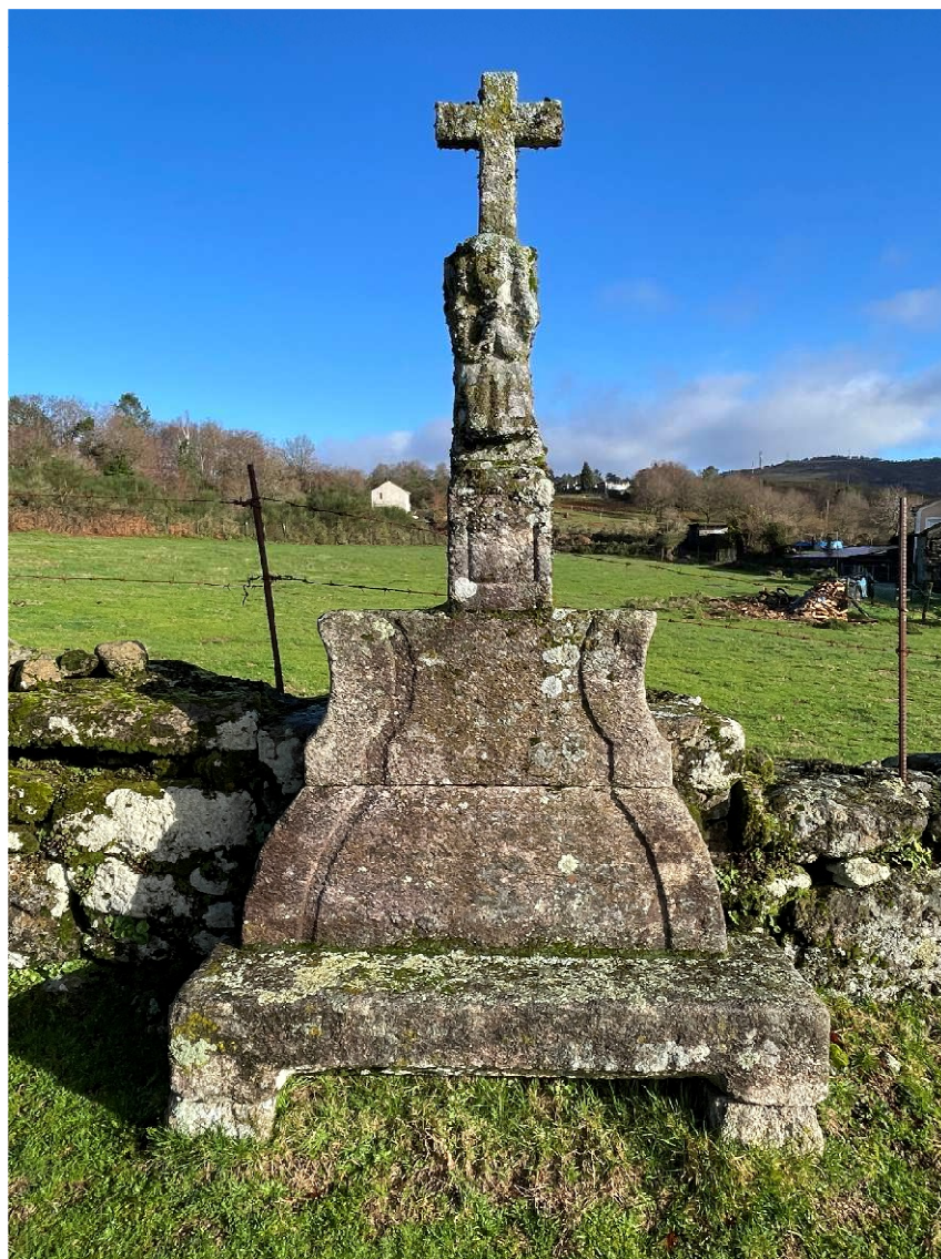
Vista frontal do cruceiro de San Salvador de Prado, que será limpo con auga e cepillos de fíos naturais (non metálicos)
