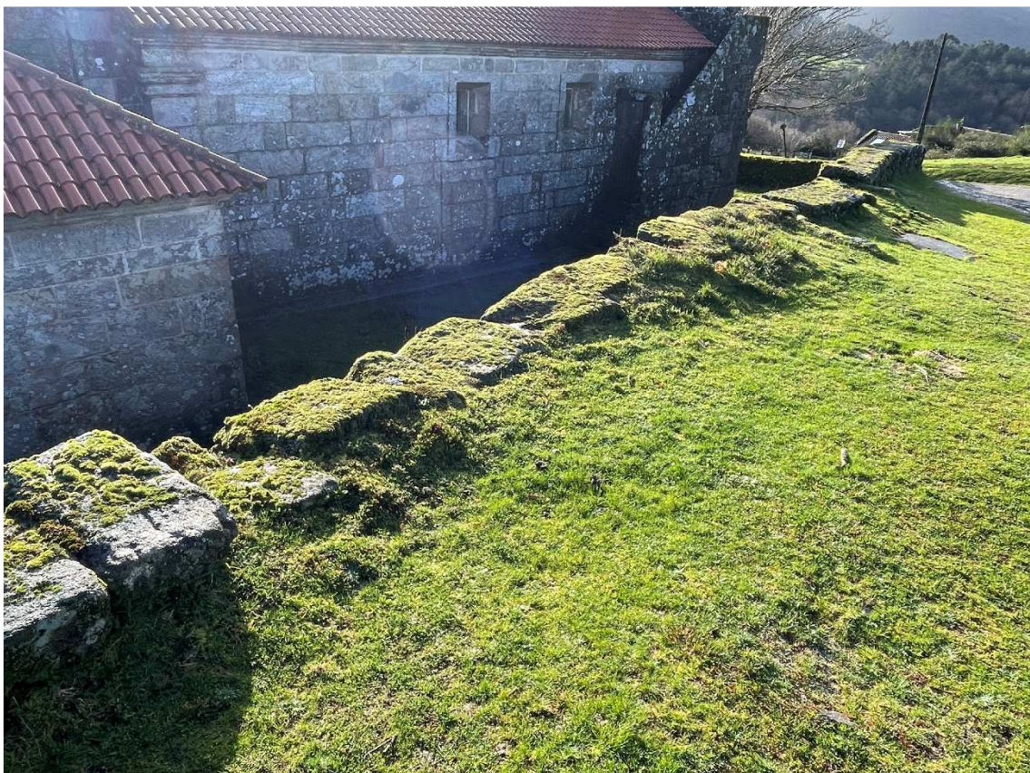
Detalle das tres únicas pedra do capiado existente sobre o muro Oeste da igrexa. Os traballos completarán a coroación con perpiaños de tamaño e forma semellantes
