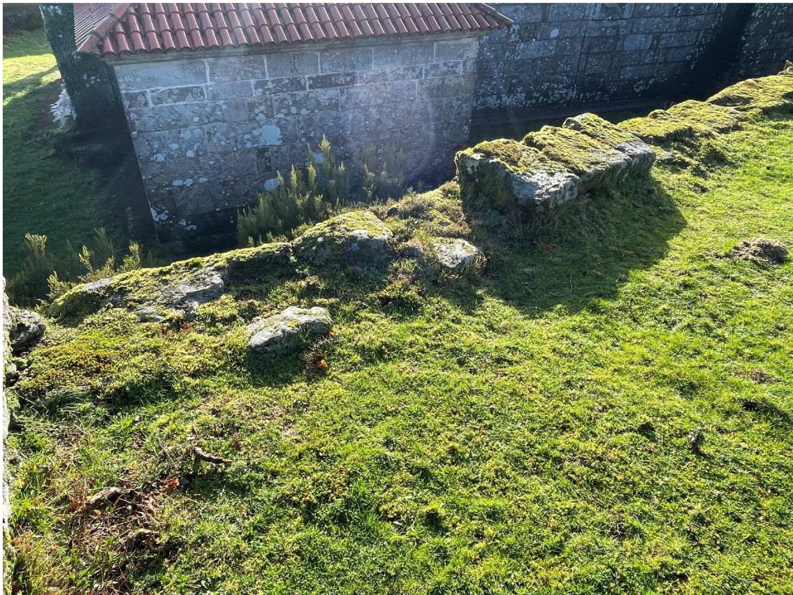
Detalle das tres únicas pedra do capiado existente sobre o muro Oeste da igrexa. Os traballos completarán a coroación con perpiaños de tamaño e forma semellantes
